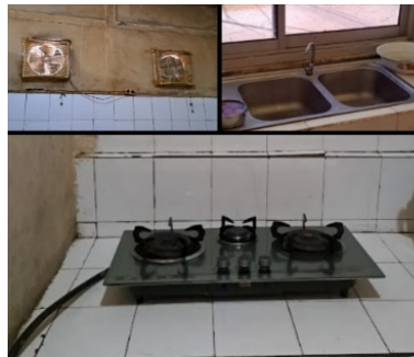
Gambar 2 Tempat pengolahan makanan memiliki ventilasi untuk mengeluarkan asap dimana kompor selalu dibersihkan sebelum dan sesudah memasak dan juga tempat cuci tangan diletakkan pada tempat yang mudah dijangkau
