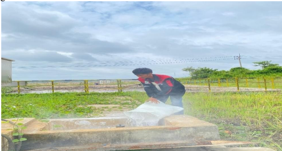
Gambar 4. Pemberian Kapur Tohor Pada Saluran Inlet
