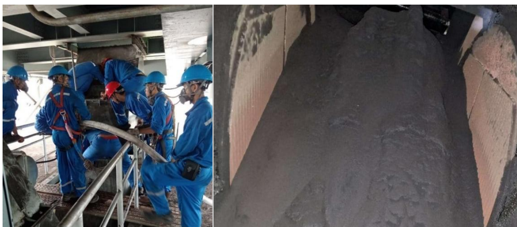
Gambar 5. Proses pembersihan Diverter Gate dari batubara yang menempel. (a). Pembersihan. (b). Diverter Gate yang batubara yang menempel.
