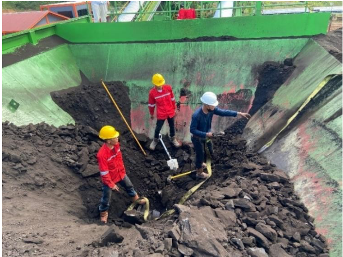
Gambar 6. Pengeluaran Batu Andesit/Peg yang Tersangkut pada Screw Sumber: Penulis, 2025
